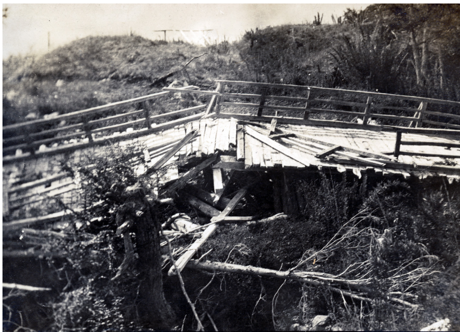
Figura 9. Uno de los puentes levantado por Ricardo 2.º Michell y sus hombres, varios años después de su construcción, destrozado por las crecidas del río, c. 1910. Fotografía del álbum Alex Urquhart. Museo Regional de Aysén, Colección Csillag, n.º inv. D001630.
