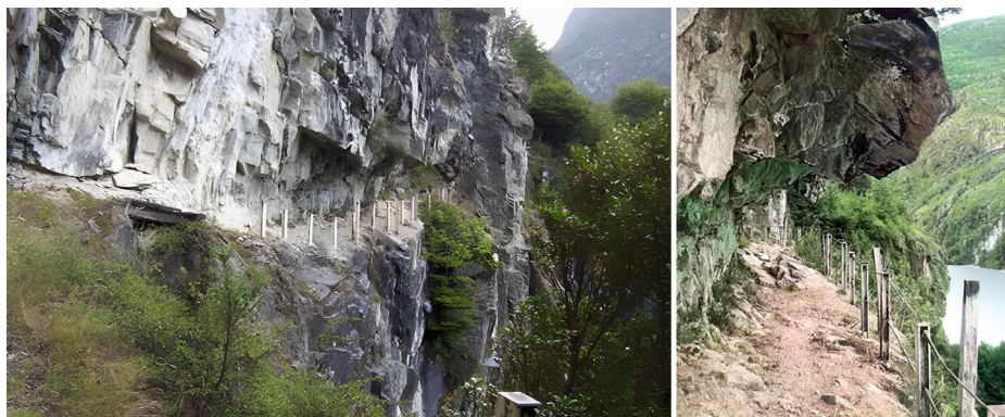
Figura 12. Dos vistas del paso San Carlos, 2006. Se observa el corte en la roca frente al saltón del río Baker, obra ejecutada por el ingeniero Ricardo 2.º Michell entre los años 1900 y 1902. Con sus distintos componentes, que se extienden por más de 600 m, el paso San Carlos fue declarado Monumento Histórico Nacional en 2014. Fotografías del autor.
