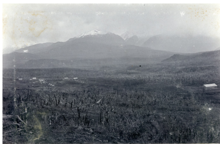
Figura 7. Vista general de las construcciones de la Estancia Coyhaique. La imagen está tomada desde una loma al Este de las edificaciones. A la derecha se aprecia el gran galpón de esquila con sus corrales. Al fondo se aprecia el cordón Huemules. Fotografía tomada probablemente por la comisión de la Marina chilena en 1910. Colección fotográfica, Archivo Fotográfico MuRAY. N° registro: FB000557.
