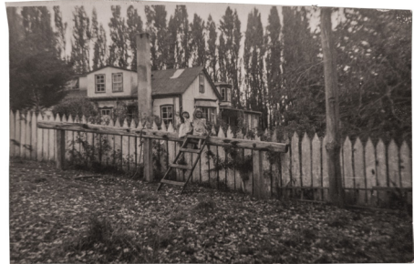
Figura 13. Casona de la administración de la SIA, donde posteriormente funcionó la Escuela Agrícola y que se demolió para construir nuevas instalaciones. Colección fotográfica, Archivo Fotográfico MuRAY. N° Registro: D000043.
