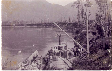
Figura 3. Descarga de materiales y desembarco de obreros en el muelle o puerto “Dun” sobre el río Aysén. Colección fotográfica, Archivo Fotográfico MuRAy. N° Registro: FB000560.
