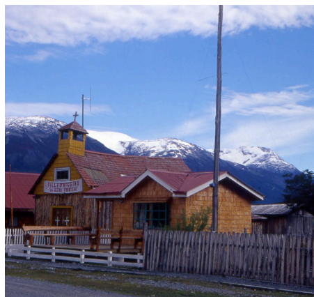
Figura 8. Instalaciones de la emisora Río Pascua, continuadora de la radio Madipro en Villa O’Higgins. Fotografía del autor.
